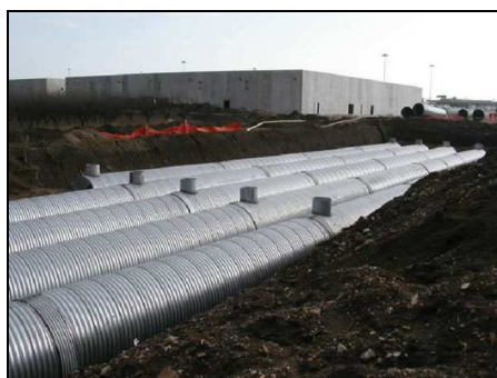
Serbatoi metallici interrati e strutture reticolari
