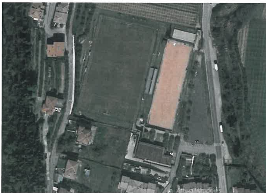
Foto aerea dell'area oggetto di intervento
