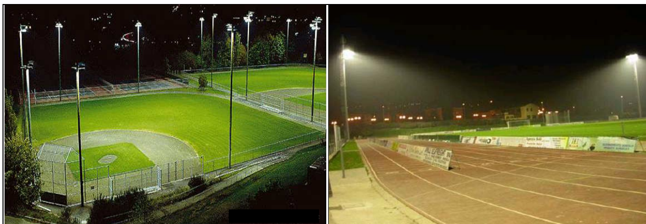
Fig. 20 – Impianti sportivi illuminati in modo conforme alla L.r. 17/09 con proiettori asimmetrici orientati orizzontalmente e che non disperdono luce verso l'alto.
