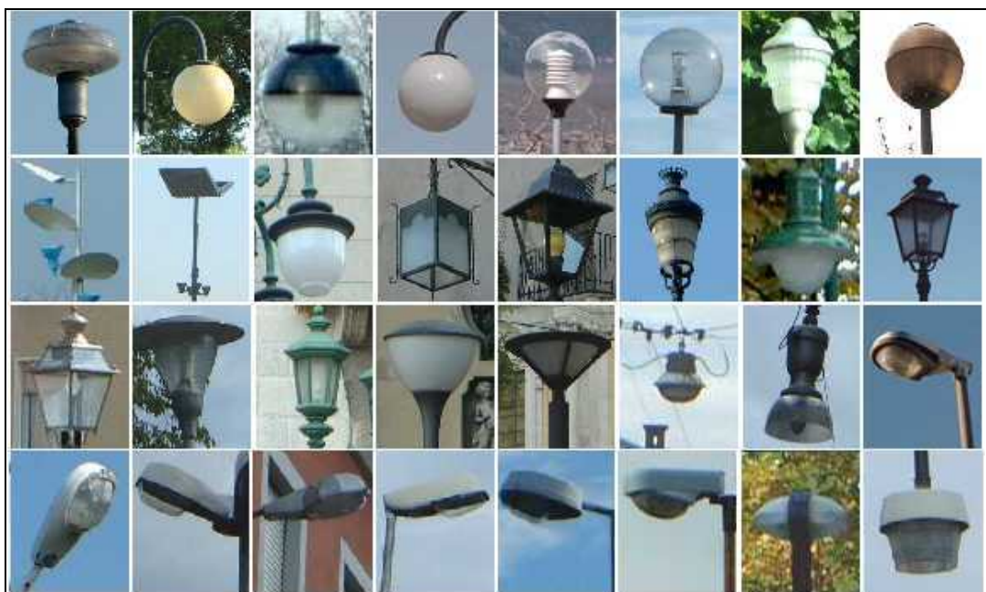
Fig.5 – Esempi di apparecchi NON conformi alla L.r. 17/09.
