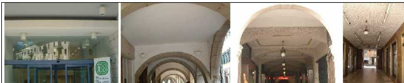
Fig. 8 – Quattro esempi di luci internalizzate: all'interno di edifici, sotto porticati e in gallerie (pedonali o stradali) o comunque dove ci sono schermi naturali che impediscono emissione di luce verso l'alto.
