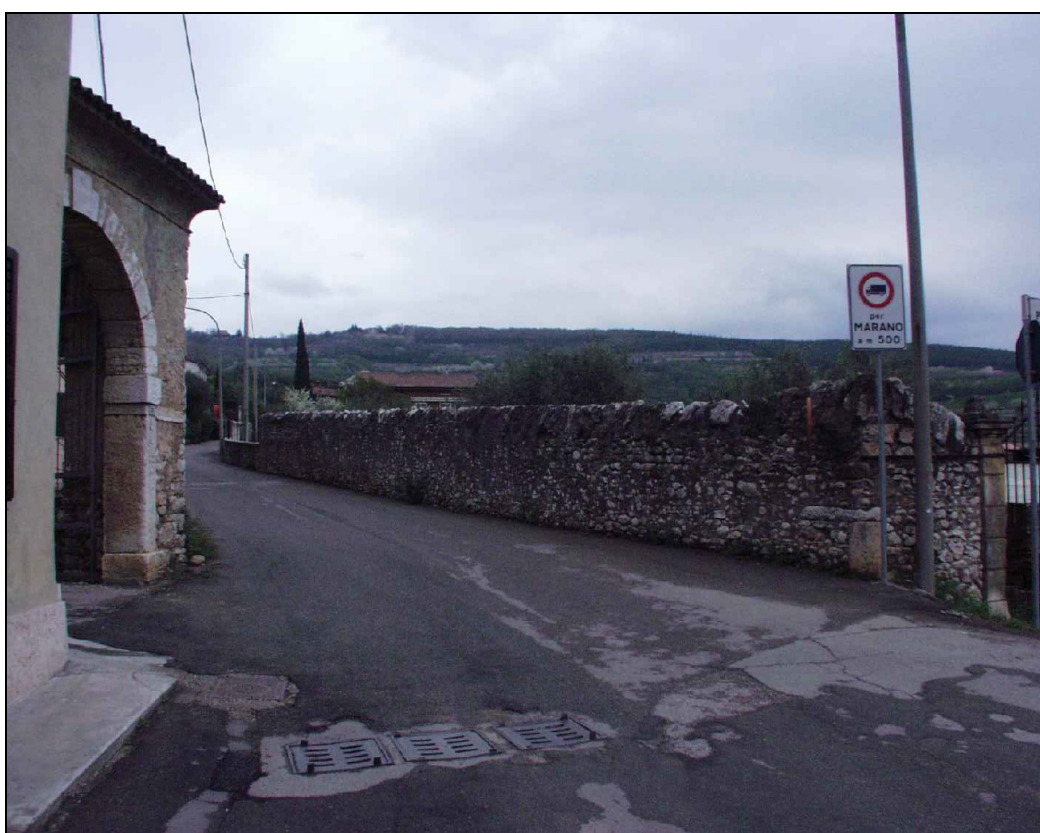
Figura F - Tratto della S.P. 33/B da riqualificare
